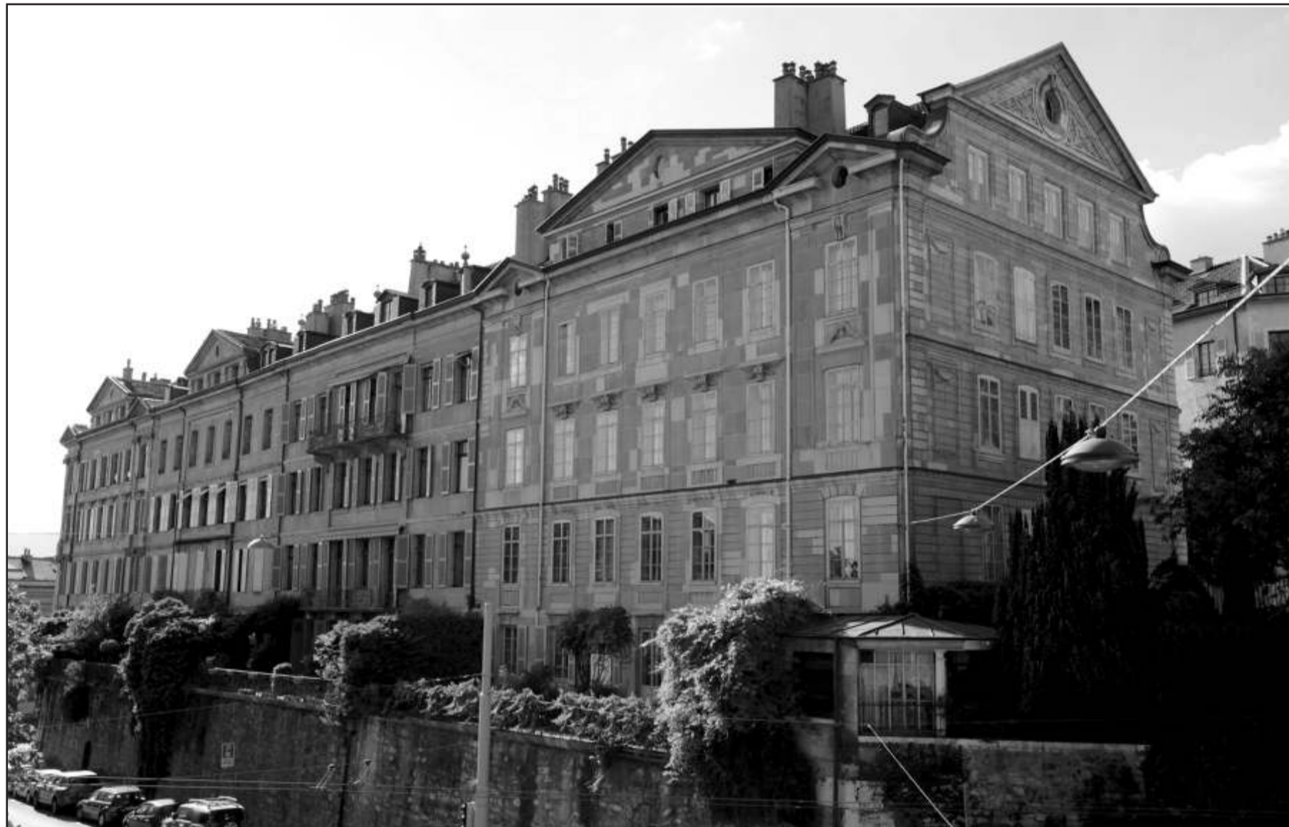
Place des casemates. Les projets cherchent à faciliter les rénovations énergétiques des bâtiments classés. J.-P. DI SILVESTRO
